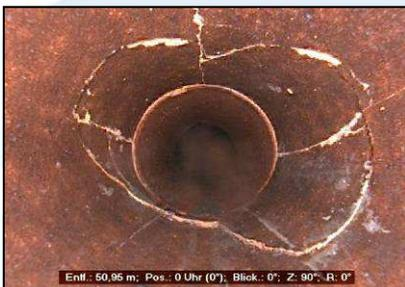
Abb.: Kanalkamerabild einer defekten Leitung (Scherbenbildung)
