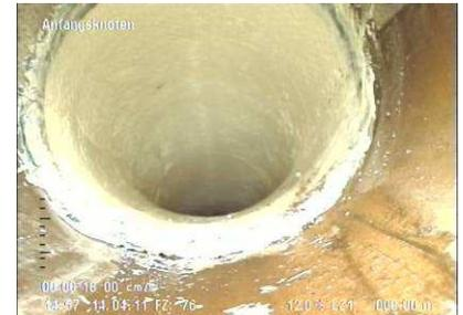
Abb.: verklebter Kurzliner in einem Abwasserrohr
