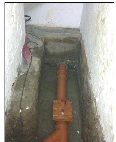
Abb.: eine erneuerte Abwasserleitung im Kellergeschoss
