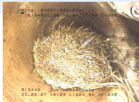
Wurzelnetz in der Abwasserleitung
